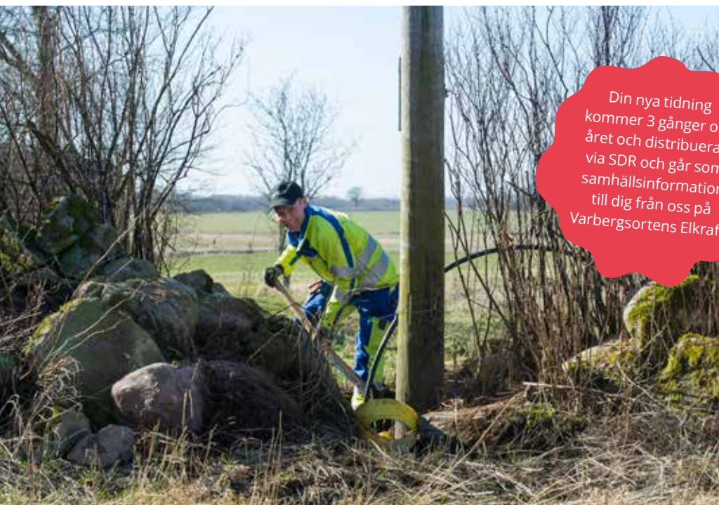
➤ Arbete med att ansluta jordkabel i vårt landsbygdsnät.
